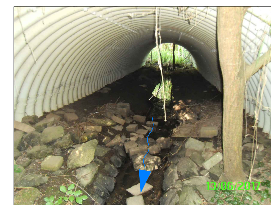
Bestehende Leiselsbachverrohrung (Hamco-Profil)
