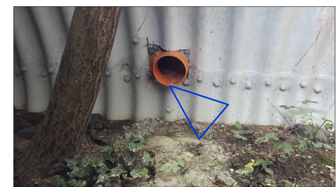
Einleitstelle 1 (Ausmündung Rohrleitung SK)
