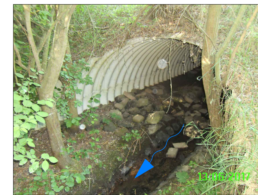
Bestehende Leiselsbachverrohrung (Hamco-Profil)
