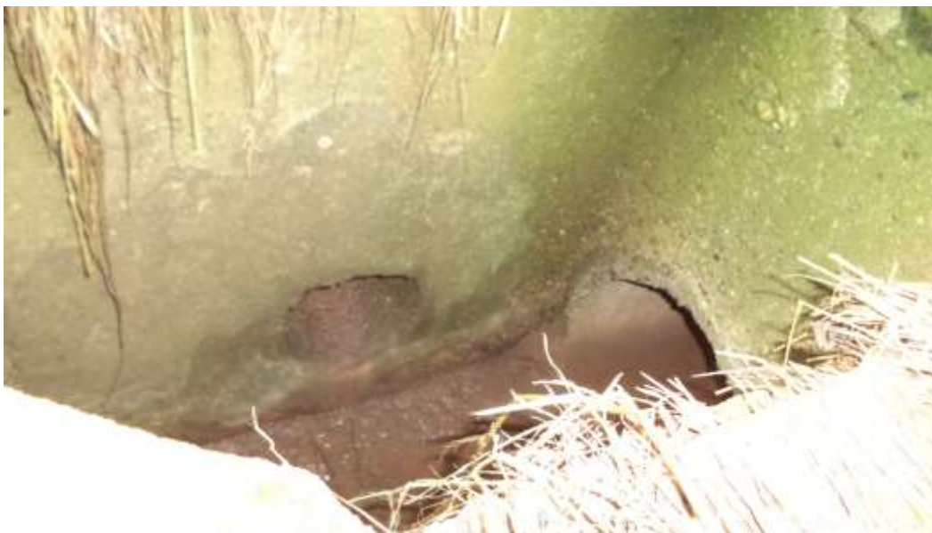
Bild 1.9.2: bestehender Zulaufschacht zum Durchlass (L 401)
