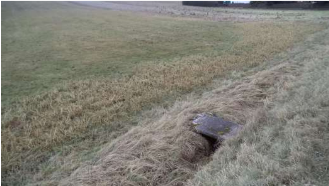
Bild 1.9.1: bestehender Zulaufschacht zum Durchlass (L 401)
